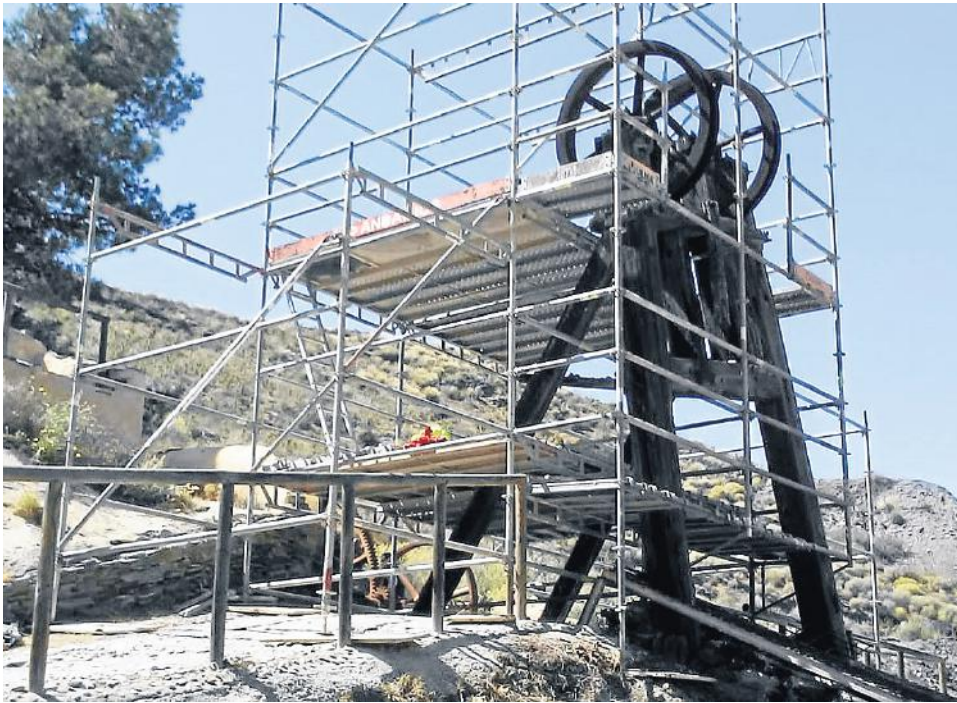
Obras en la Máquina de Vapor de Sierra Almagrera.
